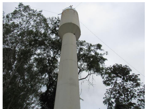
Reservatório de água
