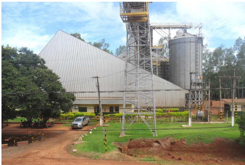
Figura 4 – Visão Geral do Terminal.
