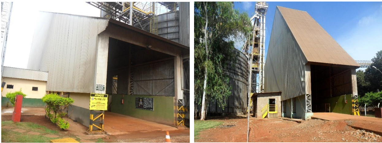
Figuras 2 e 3 - Moega, Tombador e Casa de Máquinas.
