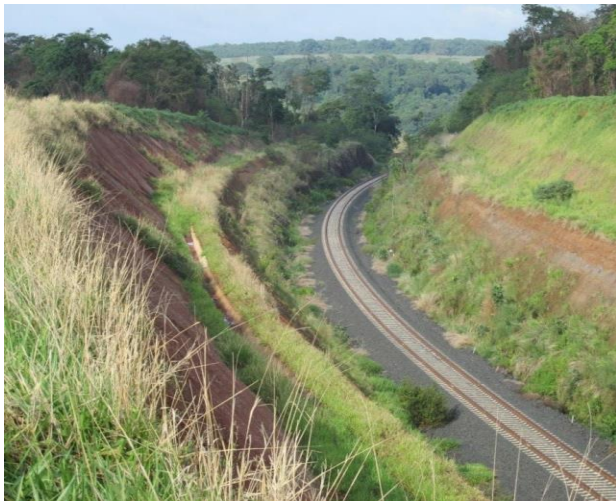
Figura 3. Corte do km 285+460 ao km 286+840.
