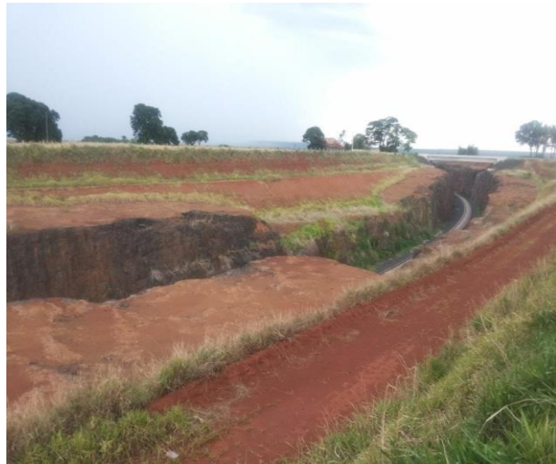
Figura 4. Corte do km 279+820 ao km 282+180.
