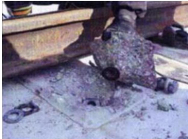
Figura 17 — Fissura cônica devido à formação de gelo na via da laje (Fonte – Zi et al, 2012)
