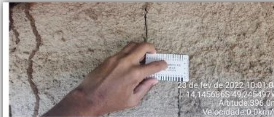
Figura 9- Rachadura em Parede dos Fundos do Depósito/Tanque Refrigerado de Leite
