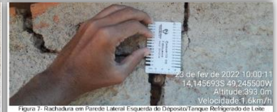
Figura 7- Rachadura em Parede Lateral Esquerda do Depósito/Tanque Refrigerado de Leite
