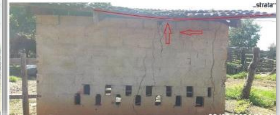
Figura 7- Rachadura em Parede Lateral Esquerda do Depósito/Tanque Refrigerado de Leite
