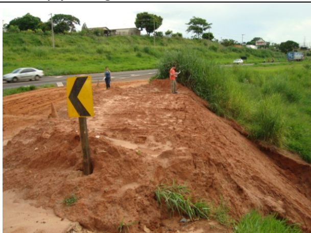
FOTO 5.4.2-15: Km 554+300 – Escorregamento/ravina junto a aterro de alça de acesso da rodovia.
