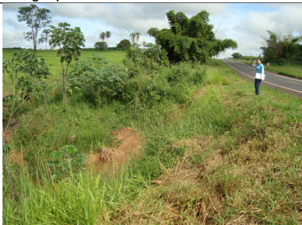
FOTO 5.4.2-3: Km 504+000 – Escorregamento estabilizado, erosão por águas pluviais.
