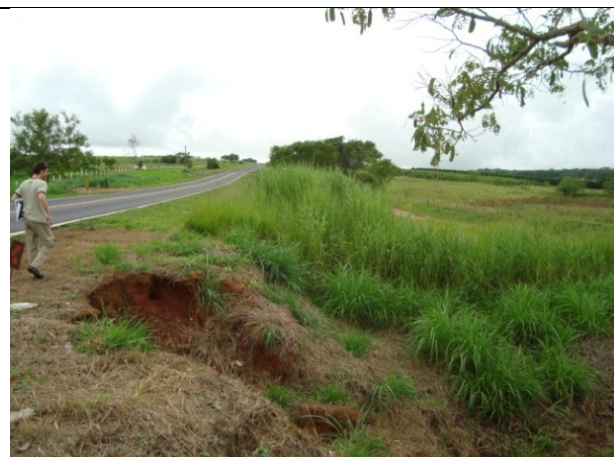
FOTO 5.4.2-20: Km 574+500 – Escorregamento em talude de aterro.
