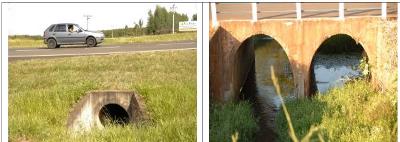
FOTO 5.5.3-57 e 5.5.3-58: Detalhe de dois modelos de transposição de drenagem existentes na SP 320 km 478+00m. A direita manilha de concreto pré-moldado utilizada somente para escoamento de drenagem e a esquerda ponte em concreto armado tipo arco servindo como passagem de fauna (corredor aquático).
