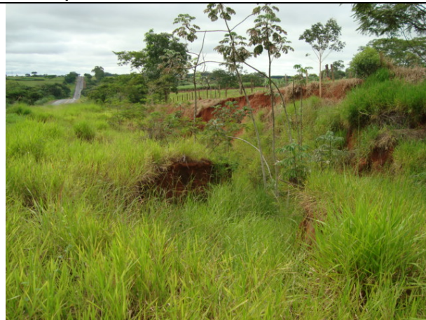
FOTO 5.4.2-16: Km 554+500 – Erosão na faixa devido a ausência de drenagem.
