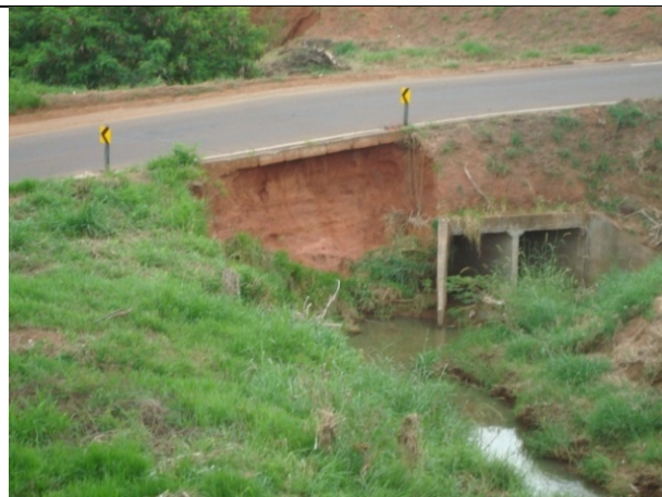
FOTO 5.4.2-14: Km 554+150 – Travessia de drenagem a ser recuperada.
