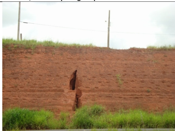
FOTO 5.4.2-6: Km 517+850 – Evolução de erosão em talude de corte.
