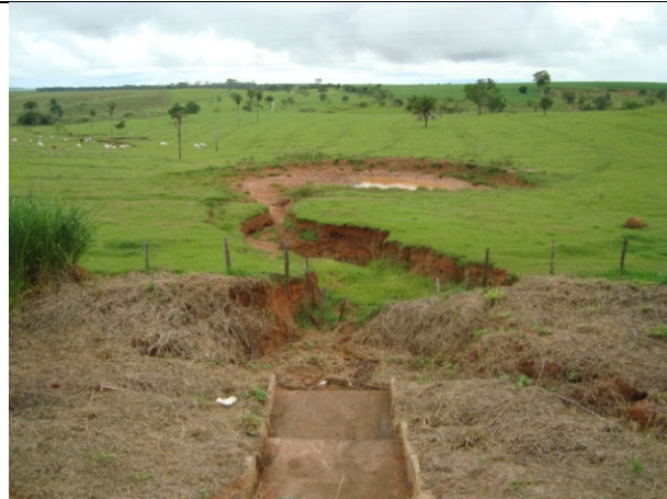
FOTO 5.4.2-18: Km 572+700 – Erosão devido a contribuição de águas pluviais da rodovia.
