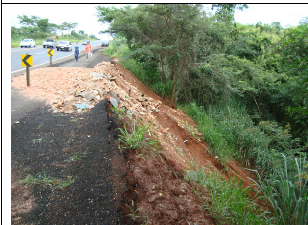
FOTO 5.4.2-9: Km 527+380 – Comprometimento do corpo estradal por escorregamento, erosões e ravinas em aterro.
