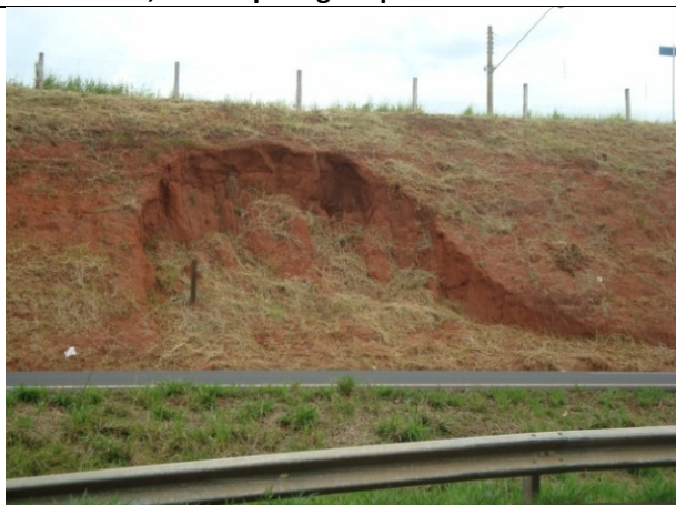
FOTO 5.4.2-5: Km 516+500 – Cicatriz de escorregamento em talude de corte
