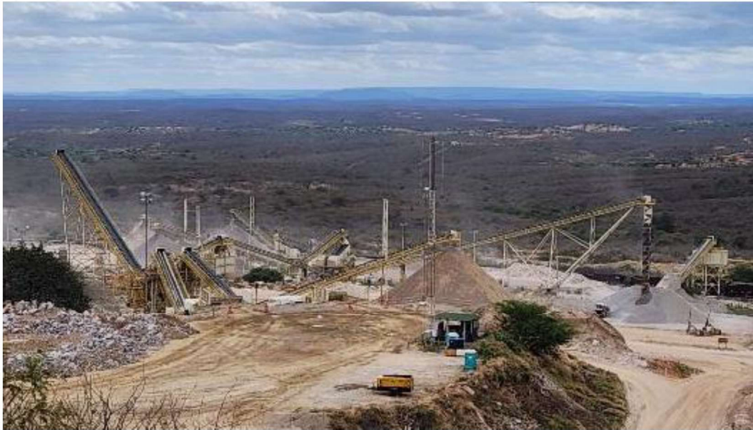
Fotografia 35 – Central de britagem.
