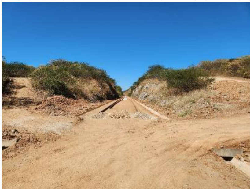
Fotografia 14 – Início da montagem da superestrutura no trecho km 248+360.
