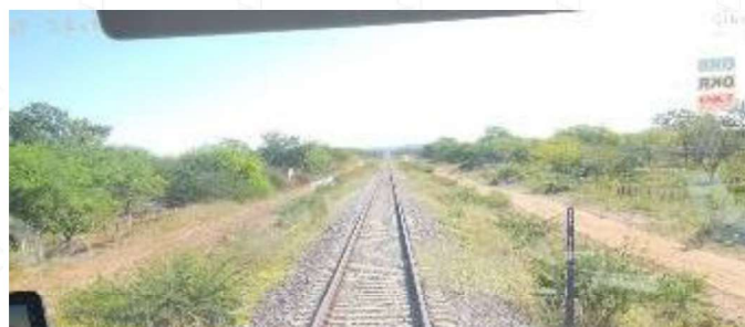
Fotografia 45 – Superestrutura montada no trecho km 111 e manutenção adequada.
