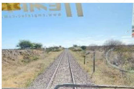
Fotografia 43 – Superestrutura montada no trecho km 87 e manutenção adequada.
