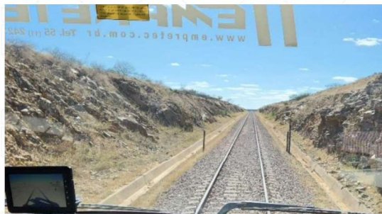
Fotografia 42 – Superestrutura montada no trecho km 69 e manutenção adequada.
