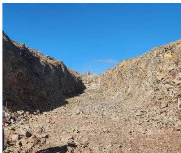
Fotografia 12 – Corte executado no início do trecho km 150.
