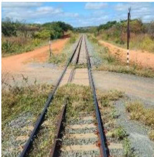
Fotografia 32 – Superestrutura montada e passagem em nível no trecho km 70.
