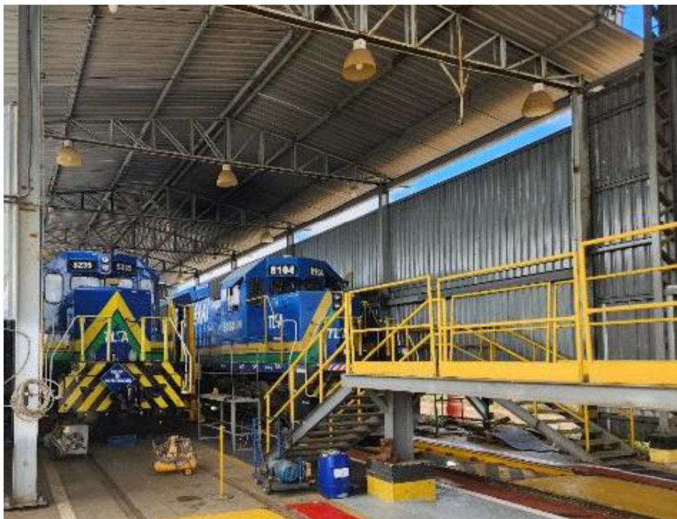
Fotografia 40 – Locomotivas dentro da officina para realização de reforma.
