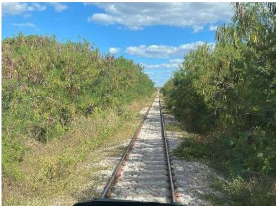
Fotografia 24 – Superestrutura montada no trecho.
