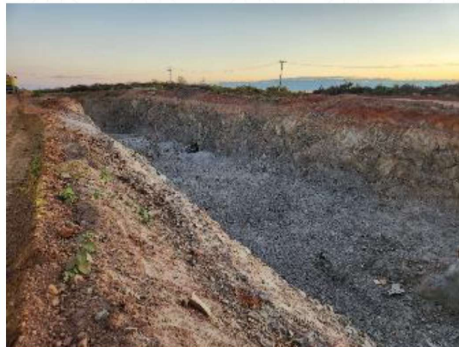
Fotografia 10 – Corte executado no trecho Km 153+300.
