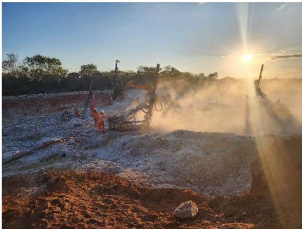
Fotografia 8 – Perfuração para colocar explosivos para escavação em rocha no trecho km 159 +800.
