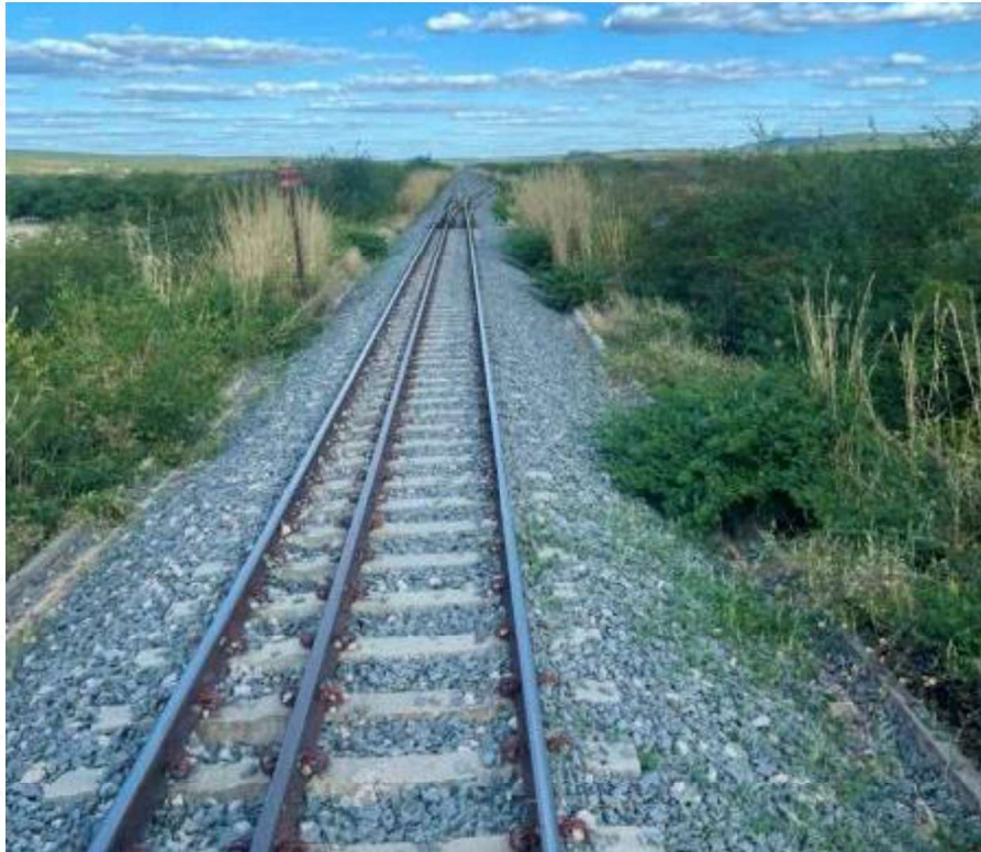
Fotografia 28 – Superestrutura montada no trecho (bitola mista, chegando ao Pátio BQM).
