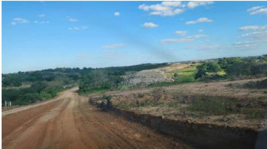
Fotografia 5 – Aterro executado no trecho km 203.
