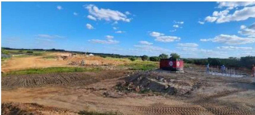
Fotografia 6 – Obra de arte especial, execução da fundação da ponte ferroviária.
