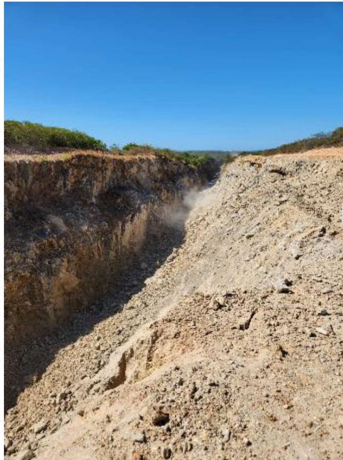
Fotografia 13 – Final do lote, escavação em 3ª categoria a ser concluída.
